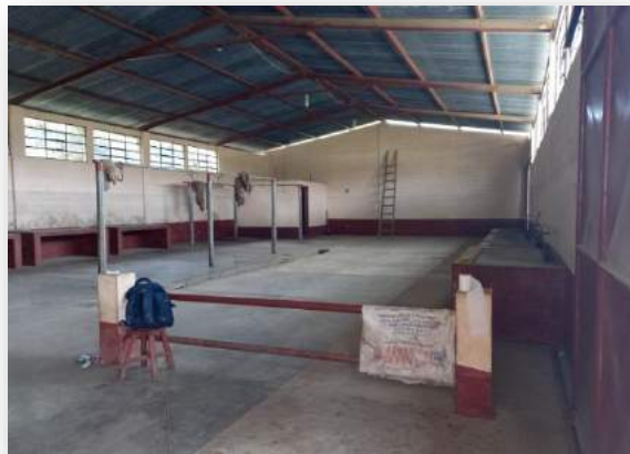
Visita al Edificio del Rastro
