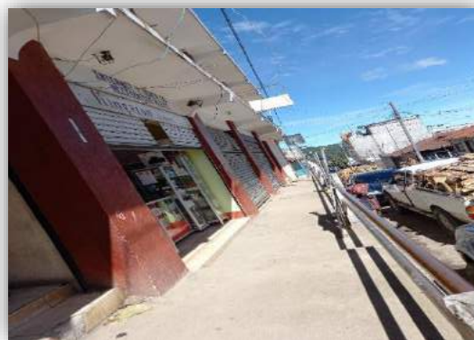
Verificación de locales
